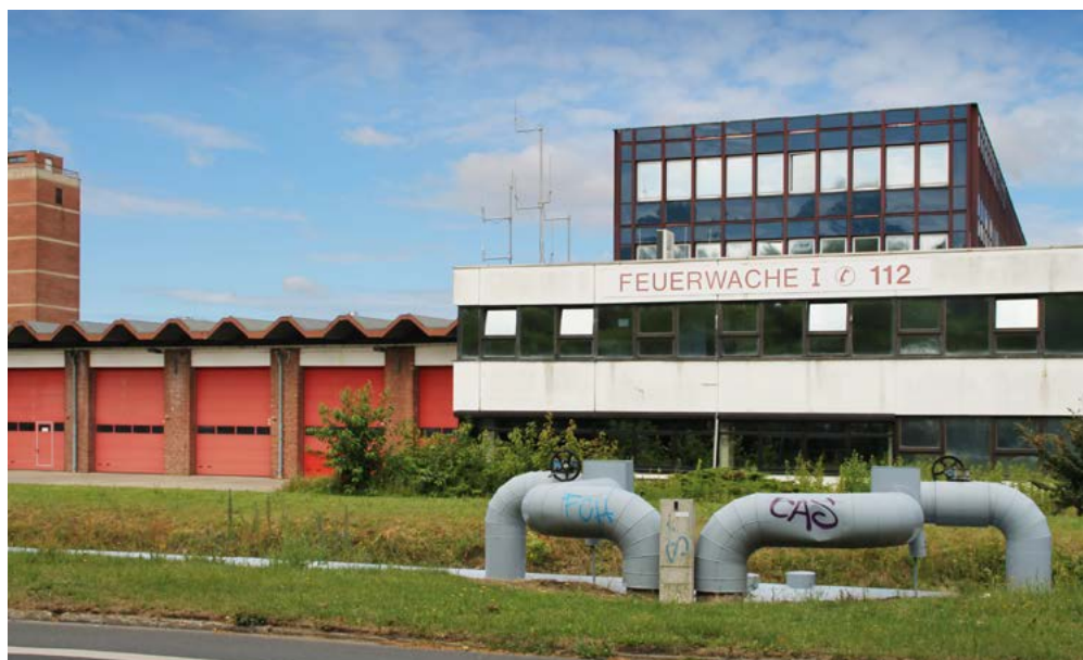
► Ab 2019 wird die Feuerwehr umfassend saniert und erweitert
