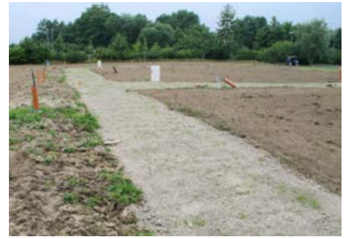
► Hier entsteht die KGA „Nobelstraße“
