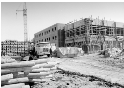
► Baustelle der Mensa in der Südstadt (Quelle:UNI-Archiv)
