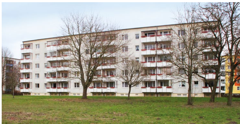
► Wohnblock Weinert-Str. 1–4: baulich intakt und trotzdem zum Abriss vorgesehen.
