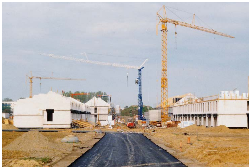
► Zechbauhäuser „Am Feldrain“ im Rohbau am 31.10.1995
