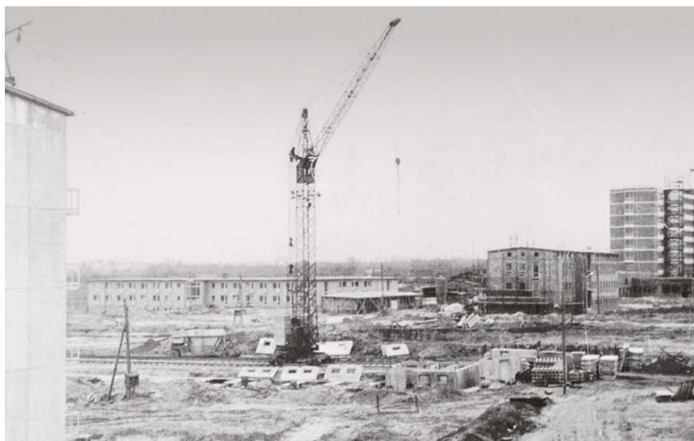
► Bauarbeiten im Bereich Hufelandstraße/Ecke Robert-Koch-Straße im April 1964
