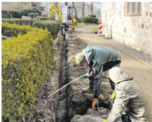
► Insgesamt wurden 203 m Kabelschächte ausgebagert.
