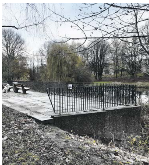
► Die Bastion wird originalgetreu wiederhergestellt.
