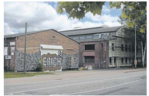
► Blick auf die „neue“ weiße Halle der Rostocker IMparat-Filiale in der Erich-Schlesinger-Straße. Das kleinere Gebäude links daneben soll abgerissen werden.
