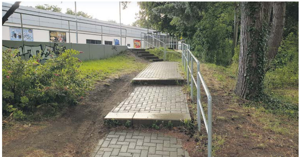
► Der Weg vom Discounter runter zum Südring ist nicht barrierefrei.
