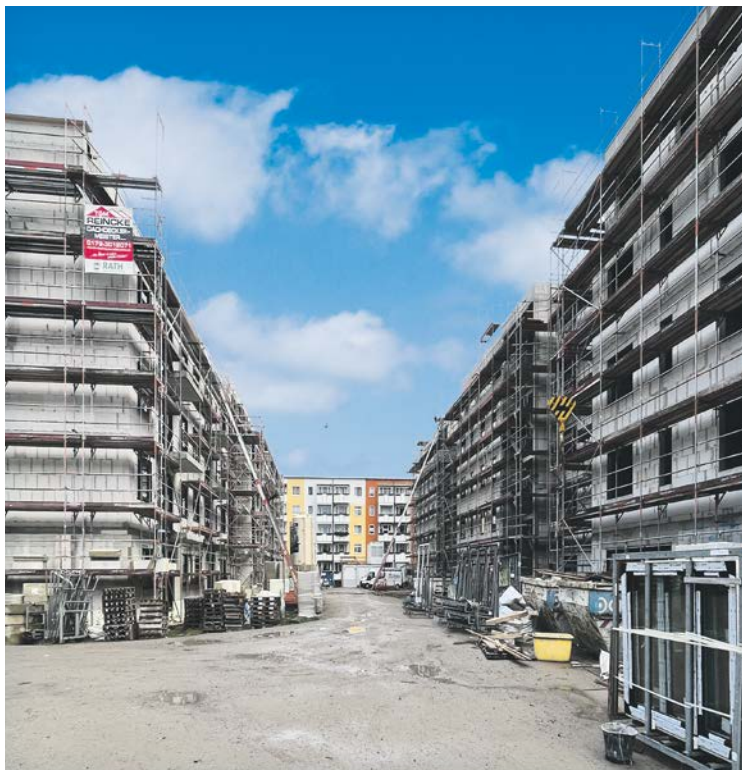
► In den neu errichteten Gebäuden in der Erich-Weinert-Straße hat bereits der Innenausbau begonnen.
