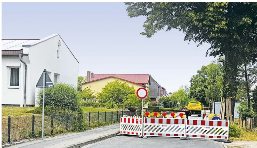
► Weiterhin gesperrt – die Fertigstellung des Biestower Damms könnte sich bis zum Frühjahr 2024 verzögern.
