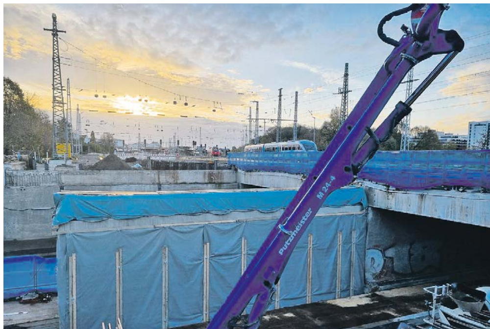
► Bauarbeiten an der Nordseite der Eisenbahnbrücke
