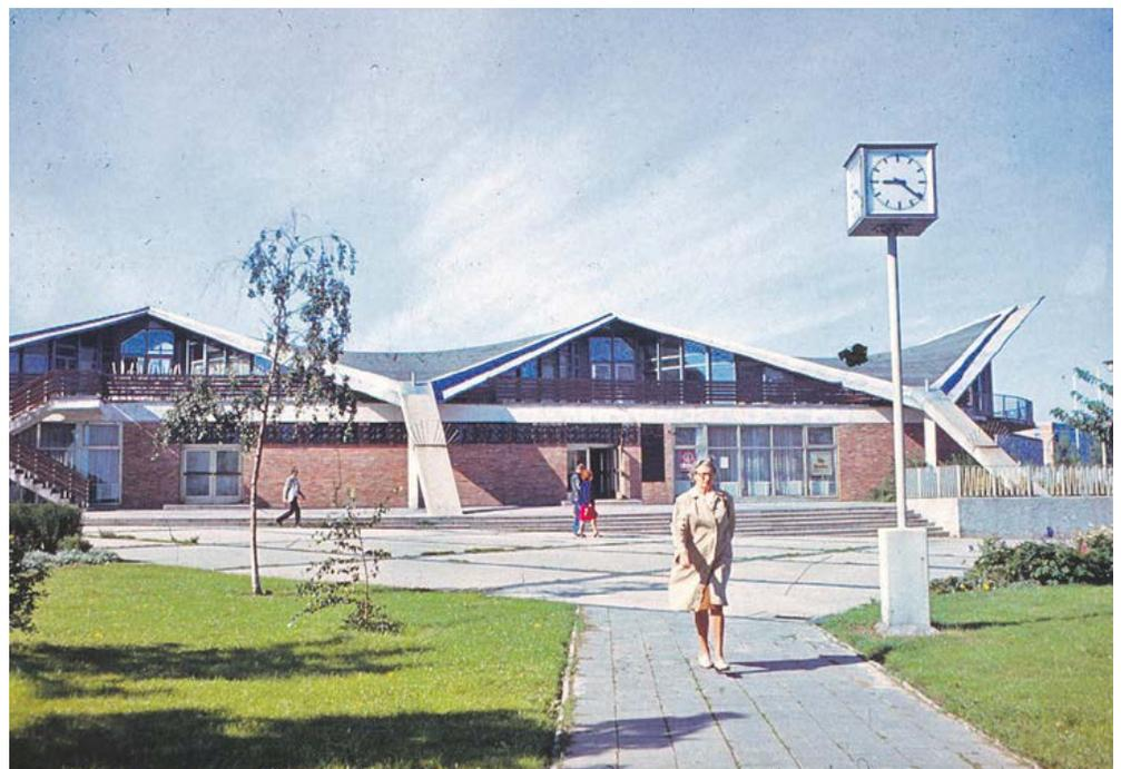
► Dieses Foto zeigt das fertige Bauwerk mit Erd- und Obergeschoss, eingebaut unter den Ulrich Müther-Dachschaalen in Nordostansicht.
