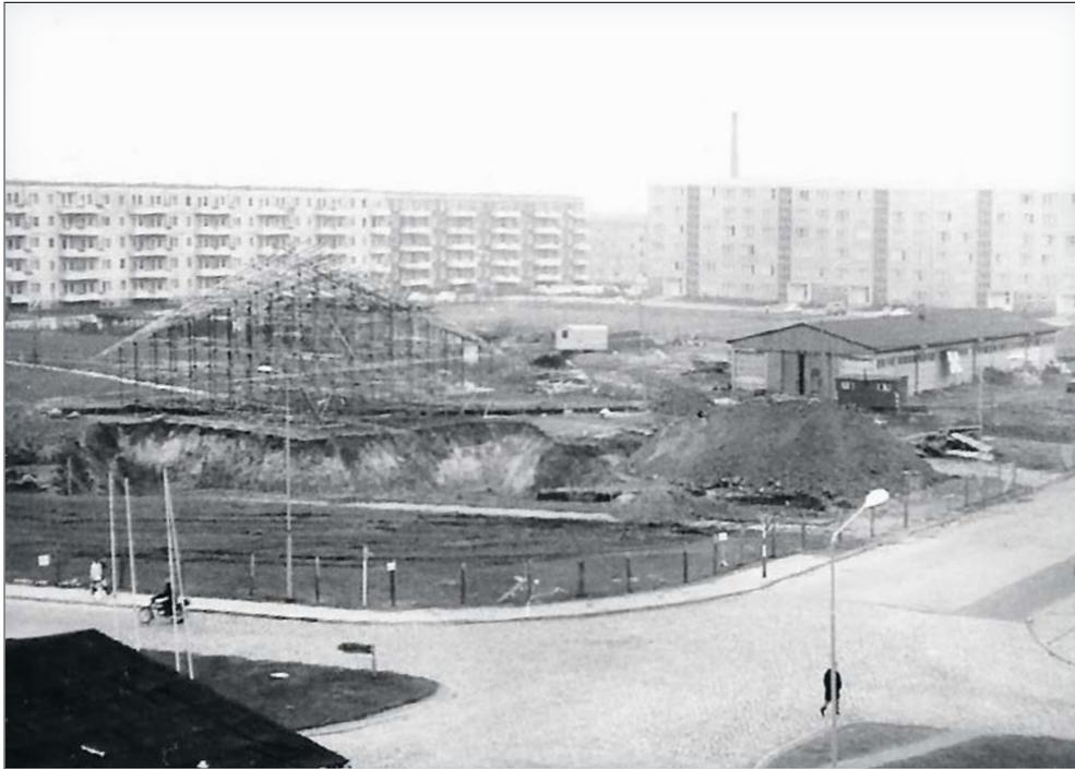
► Auf dem Bild aus dem Jahr 1968 ist ein Teil der Stützkonstruktion für die Fertigung der Dachschaale des Mehrzweckgebäudes zu sehen.
