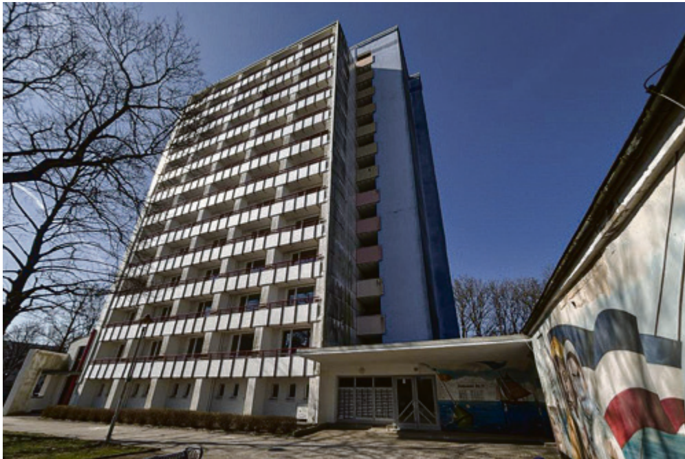
► Das Hochhaus Ziolkowski-Straße 11 soll abgerissen werden.
