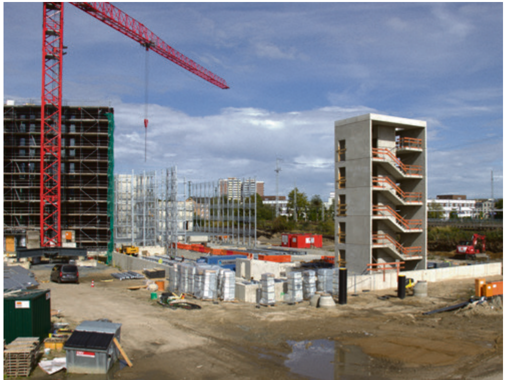
► Blick auf die Baustelle des großen „Parkdecks“ hinterm „Kesseldeck“ mit geplanten 645 Pkw- und 115 Fahrradstellplätzen sowie mehr als 100 E-Ladepunkten.
