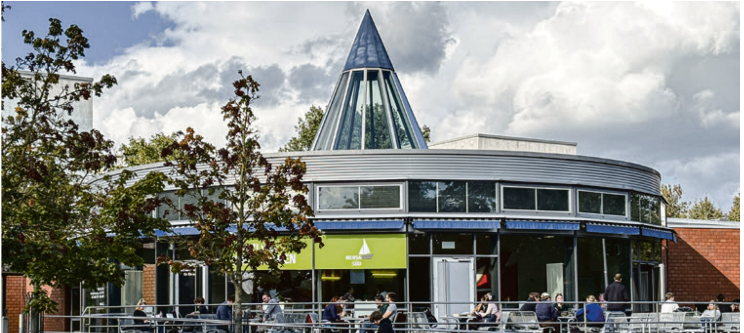
► Die erst 26 Jahre alte Mensa wird abgerissen.
