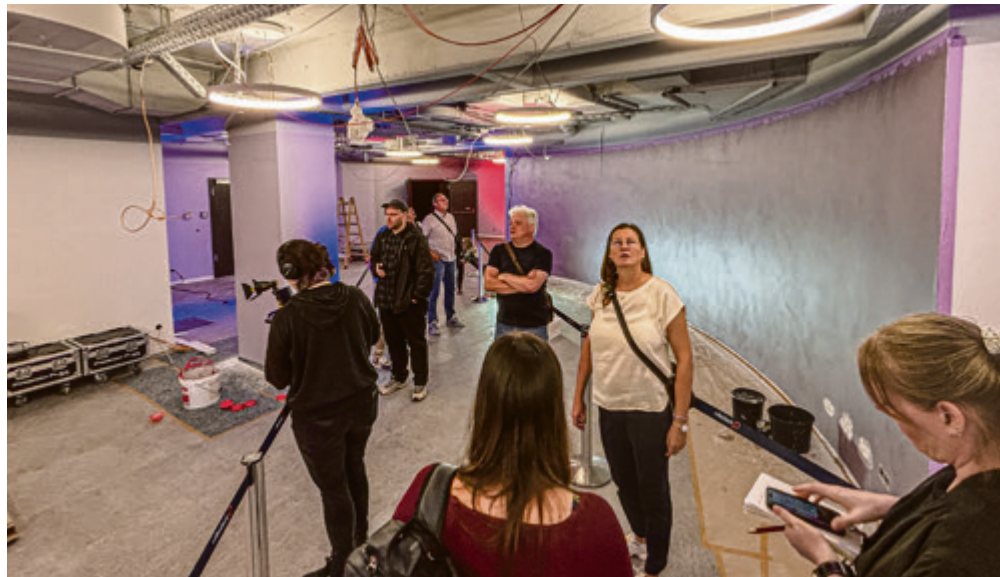
► Seit vielen Jahren arbeitet Innenarchitektin Katrin Lübs (M.) für die Stadthalle. Hier erklärt sie der Presse den Umbau des kleinen Foyers, kurz vor der Fertigstellung.
